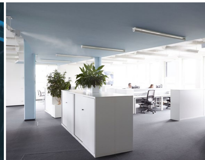
Umidificazione in un ufficio
